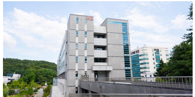
충남대학교 공과대학 5호관입니다. 이 건물의 4층에서 6층까지 컴퓨터융합학부의 강의실과 교수 및 학생들의 연구실이 자리하고 있습니다.
